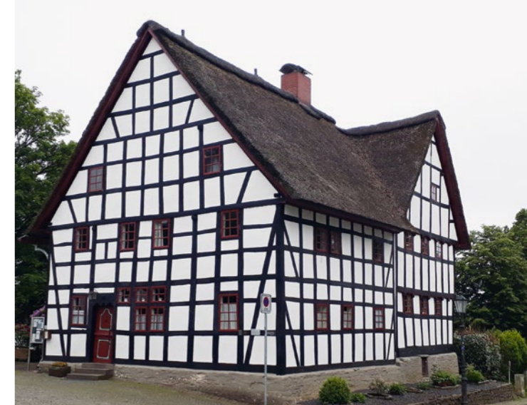
Das denkmalgeschützte Dorfgemeinschaftshaus „Weisses Pferdchen“ in Hohkeppel soll zu einer Pilgerstätte umgebaut werden, wofür über 110.000 Euro beantragt wurden.
